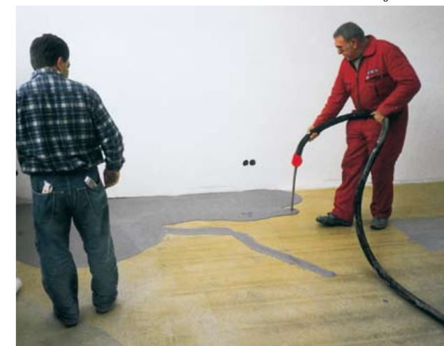
Zelfs cement-egaliseermassa kan met de universele wormpompen verwerkt worden (hier bij. Door een S 5 EV ™ in een produktiehal).
