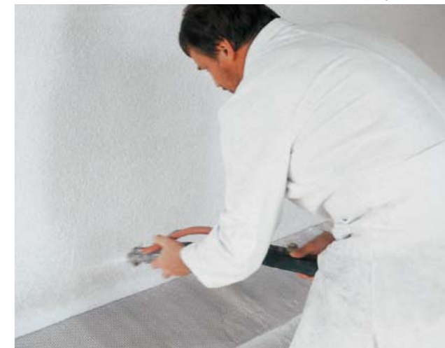
Wormpompen type S 5 en SP 5 kunt U bij alle verpompbare mortels tot 6 mm korrelgrootte inzetten. Variërend van normale basispleister (grote afbeelding), decoratieve sierpleister...
